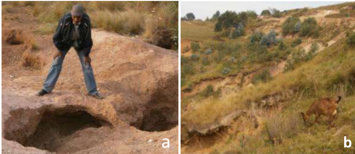
Photo 17 : Illustration de trous et tunnels laissés après l'abandon des sites d'extraction minière en communes Tangara (a) et Kabarore (b).
